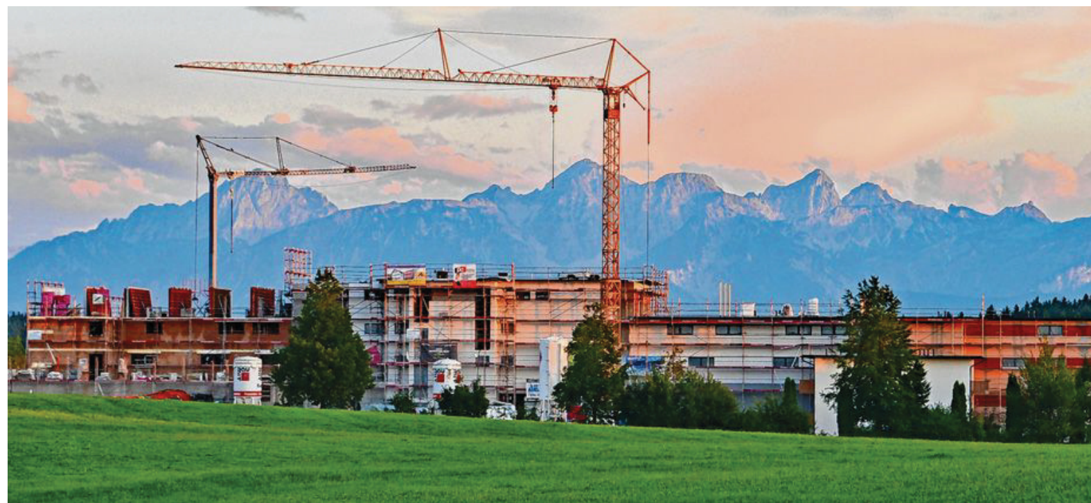
Eines der aktuellen Projekte der Unterallgäuer Bauunternehmung Brefa ist das Hotel „Weitblick“ in Marktoberdorf. Den Weitblick sollen die Gäste genießen, wenn ihre Augen bei schönem Wetter zur Alpenkette wandern.
